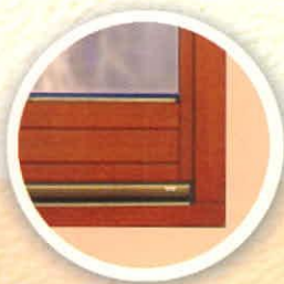
erkélyajtó alsó kiképzés tokküzöbös kivitel
